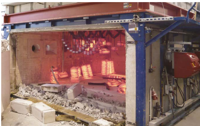
Dopo il test al fuoco
