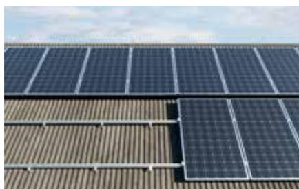
Copertura inclinata con rivestimento in lastre ondulate.
