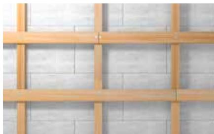
Sottostrutture in legno.
