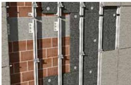
Sottostruttura montanti verticali
