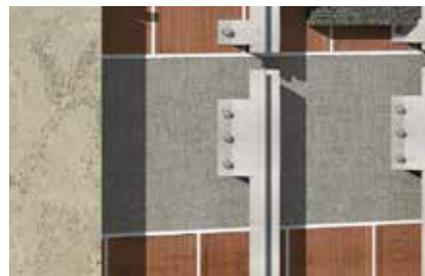
Dettaglio: fissaggio profilo VP alla staffa
