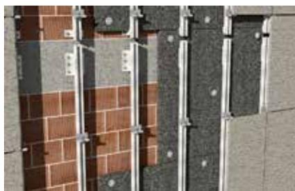
Sottostruttura montanti verticali
