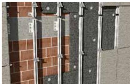
Sottostruttura montanti verticali
